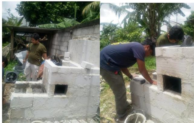
Gambar 6. Proses Pembuatan Tungku Pembakaran Menggunakan Konsep Rocket Stove
