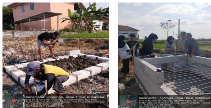
Gambar 1 Proses Pembangunan TPA Rocket Stove
